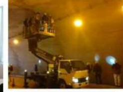
高所作業車による近接点検
