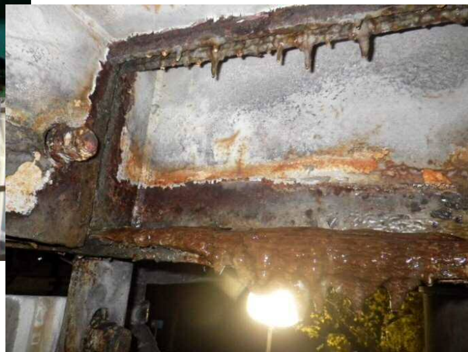
(横断歩道橋上下部接合部の腐食 III判定)
