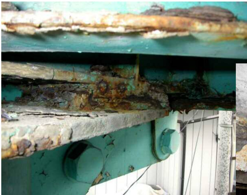
(横断歩道橋支承本体の腐食 III判定)
