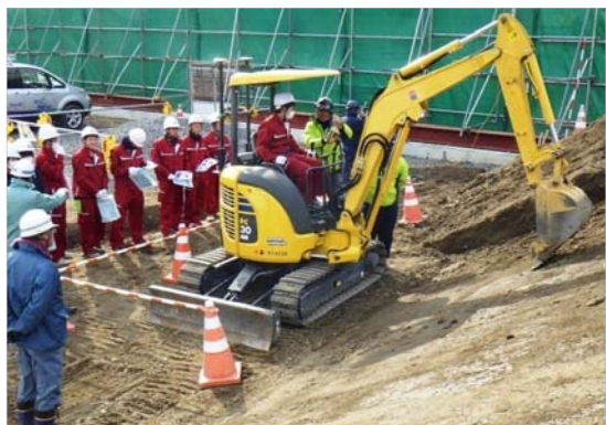
高校生を対象にICT土工体験(重機操作体験)
