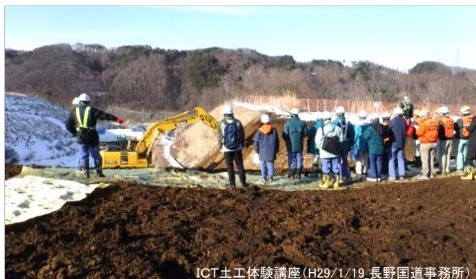
ICT土工体験講座(H29/1/19_長野国道事務所)
