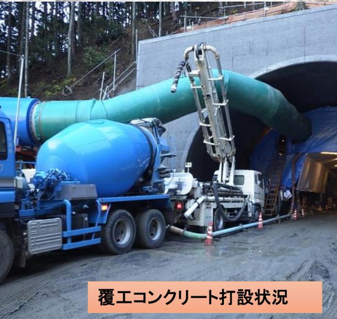
覆工コンクリート打設状況
