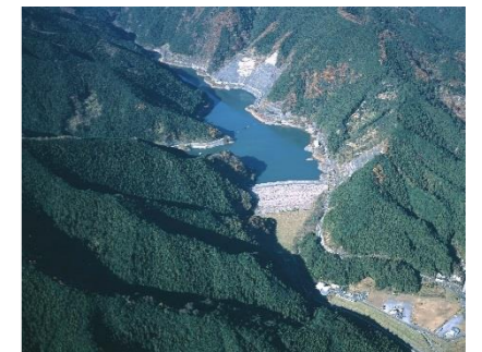
飯能市にある有間ダム。このダムは洪水を調節するほか、田畑のかんがい用水や都市用水を確保しています。
