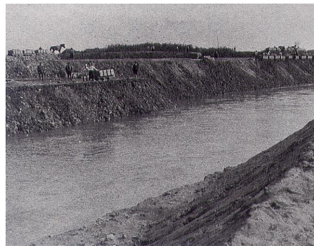
馬宮付近の堤防建設のようす(さいたま市) 画像提供:馬宮西小学校
