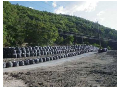
下坪上沢（上：着工前、下：施工後）
