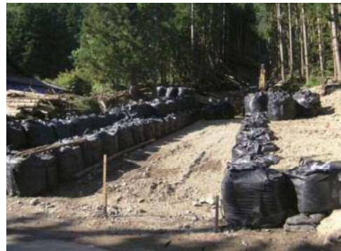
中坪上沢（上：着工前、下：施工後）
