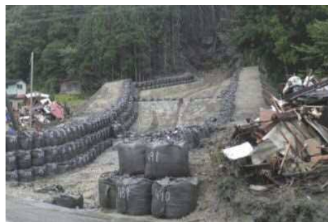
応急対策工事完了（滝向沢）
