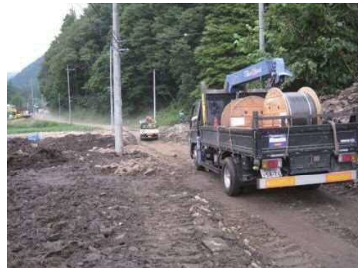
ライフラインの復旧が急がれた
