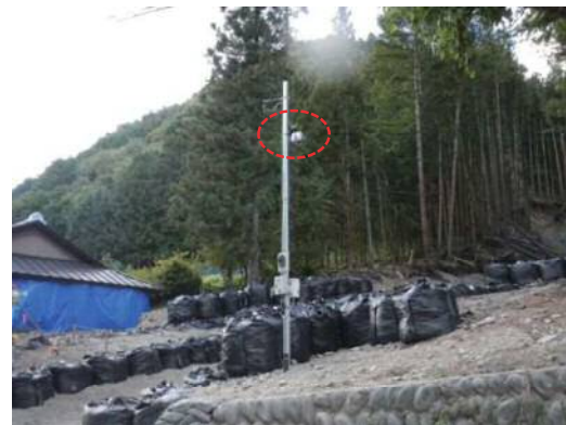
溪流監視カメラ（中坪上沢）
