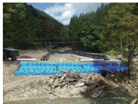
中坪下沢（上：施工状況、下：施工後）
