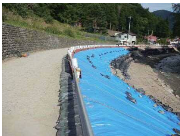
道路復旧完了状況
