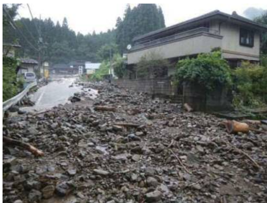
国道 121 号の状況 流出した土砂が堆積
