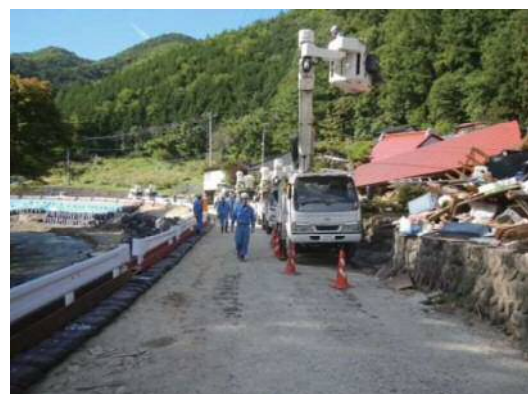
東京電力による電線・電柱の復旧作業
