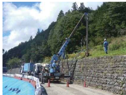
復旧工事の実施状況
