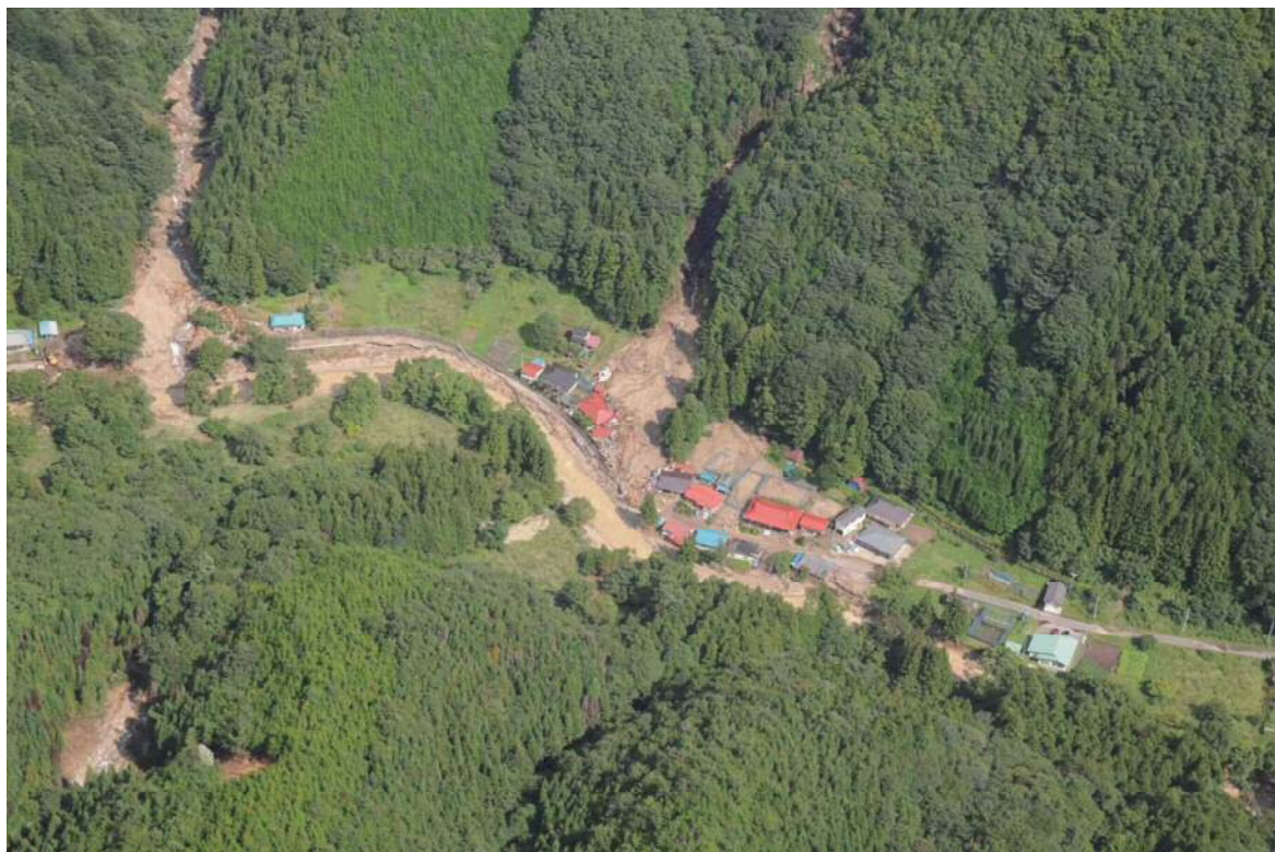
ヘリコプターより確認された被災状況(芹沢地区滝向沢～中坪下沢)
