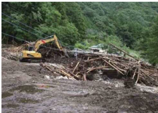
市道上に堆積した土砂・流木の状況
