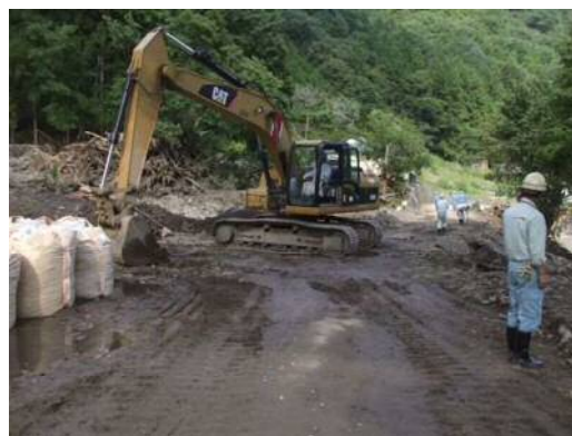
堆積した土砂・流木の撤去完了状況
