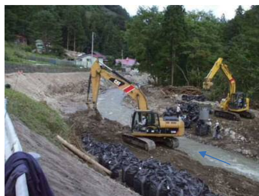
流出土砂を利用した大型土のうの作成
