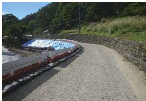
道路復旧工事完了（市道芹沢線）
