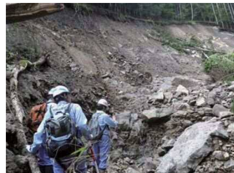
侵食の進む溪流で土砂量を計測
