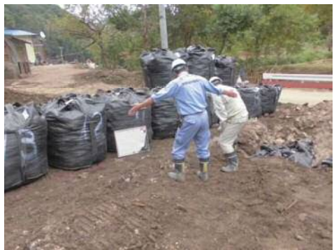
現地での指示状況(上下：隣接する家屋の保全を考え応急対策工事は現地での指示が中心であった)
