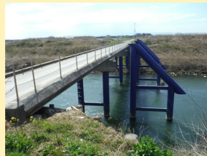
鋼製の流木除けのある冠水橋
