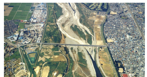
瀬切れの発生状況（1992（平成4）年9月）
