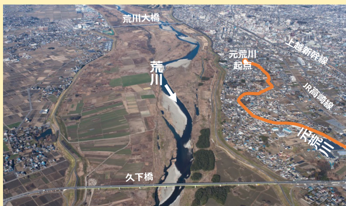
瀬替えが行われた箇所付近の現在の様子
