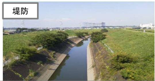
川の流れ（洪水）を氾濫させないために、土を盛り固めて築造したのが**堤防**です。また、堤防法面が川の流れて浸食されないようにコンクリートブロックなどで保護しているのが**護岸**です。
