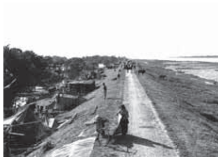
堤防上の避難状況
