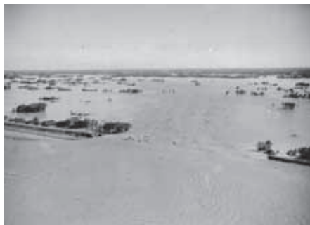
利根川右岸の決壊状況
