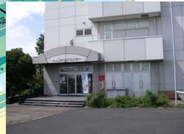
彩湖自然学習センター 東京外かく環状道路
