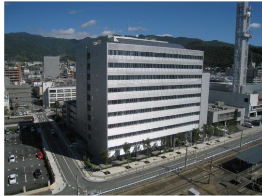
庁舎南西面全景
