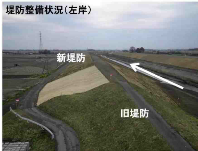
秋山川堤防整備状況
