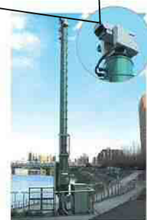
監視用カメラの増設
