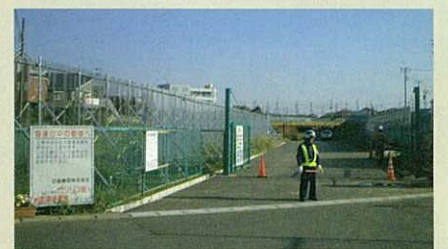
一般道路と搬入路の交差箇所では安全に配慮して仮囲いを透明にしています
