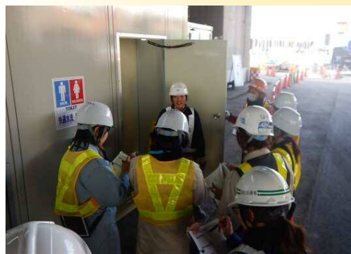
現場点検（快適トイレ）
