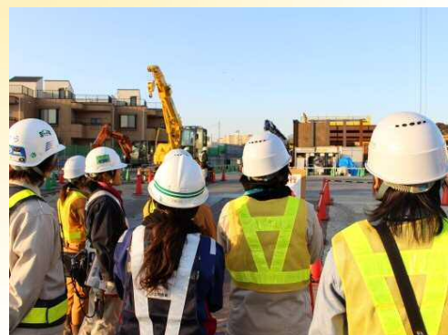
現場点検（安全通路）
