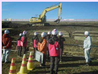
工事内容についての説明
