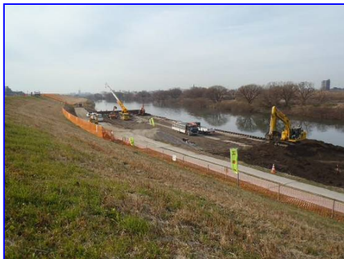
H29. 1. 18日(水)工事現場の状況写真
