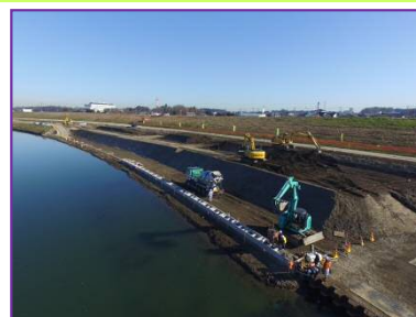
H29. 1. 18日(水)工事現場の状況写真
