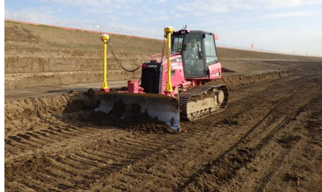
【MC(マシンコントロール)ブルを活用した盛土作業状況の事例】
