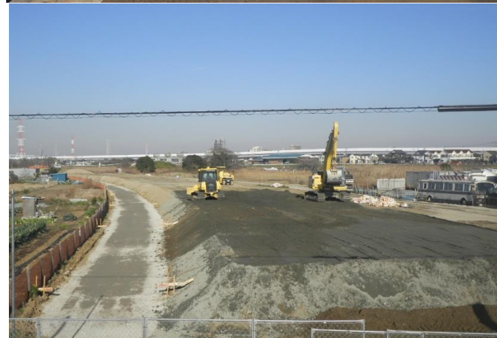
【MC(マシンコントロール)ブルを活用した盛土作業状況の事例】
