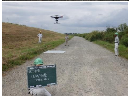
【UAVによる起工測量の事例】
