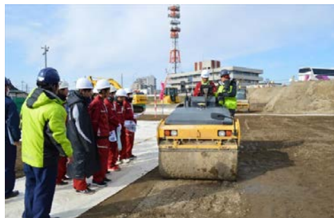
GNSSを用いた締固め
