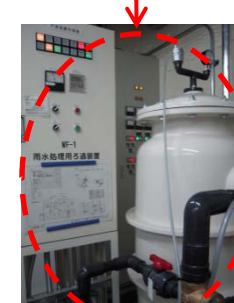
機械室:雨水ろ過設備
