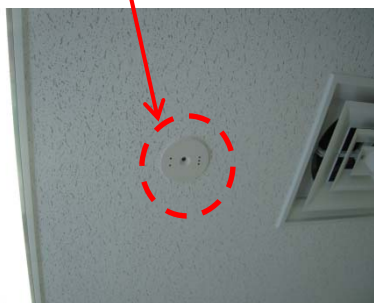
事務室:照明制御(調光センサー)
