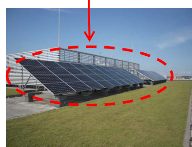
屋上:太陽光発電
