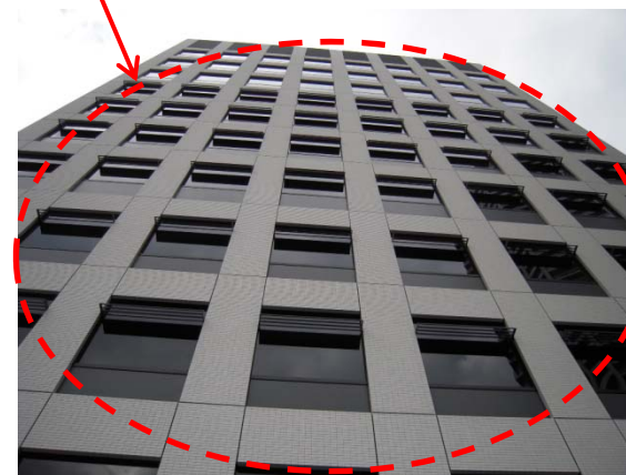
住宅に配慮し覗き込み防止フィルムを窓に設置
