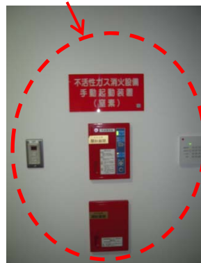
ガス消火設備
