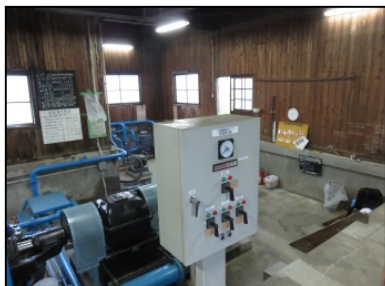
【旧機場操作盤】
