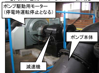
【商用電源によるポンプ駆動】
