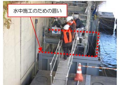
今回、現場見学会を実施したH27荒川下流堀切菖蒲水門耐震対策工事では、綾瀬川の中に水中施工のための囲いを設置し補強鉄筋挿入のための穴を開けている現場を見てもらいました。
