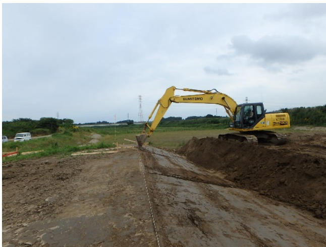
バックホウ(掘削・法面整形)
