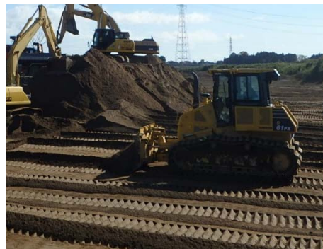
ブルドーザ(敷均し)
