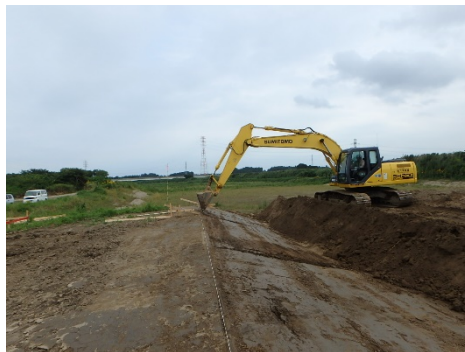
バックホウ(掘削・法面整形)
