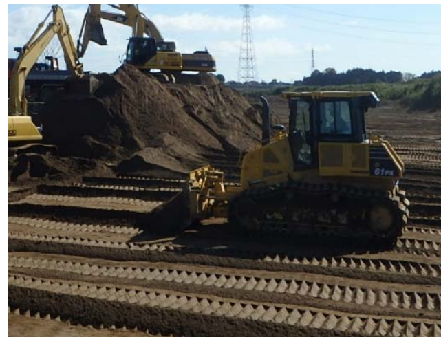
ブルドーザ(敷均し)
