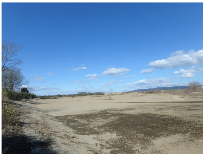
写真②：完了後(下流から上流を望む)
