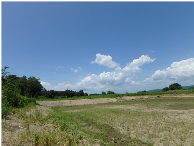
写真①：着工前(下流から上流を望む)
