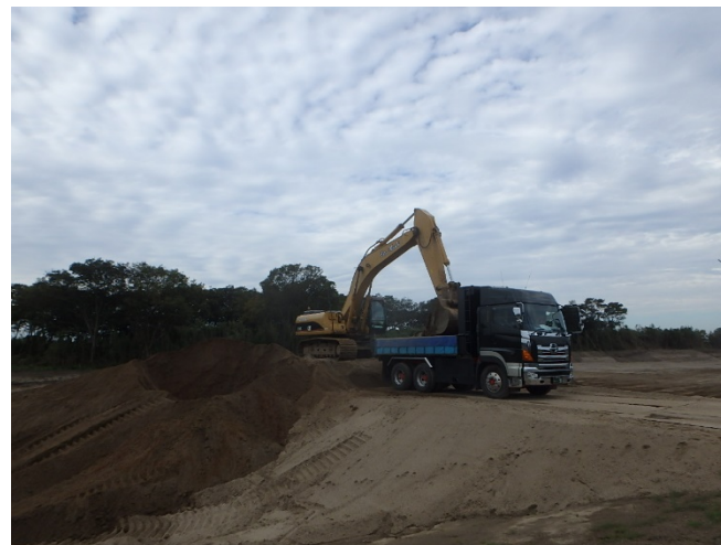
ダンプトラック積込み状況
