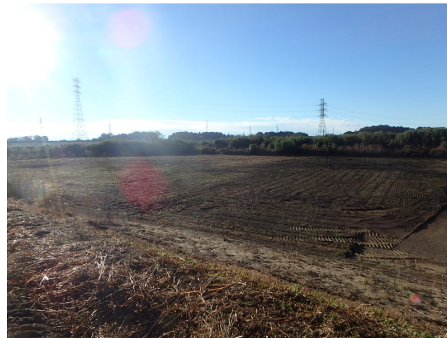
写真③：着工前(上流から下流を望む)
