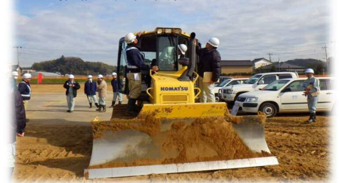
ICT搭載の建設機械(MCブルドーザ)
