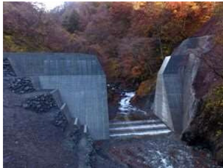
完成(一期工事)
