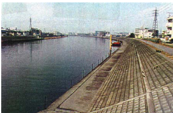
図 3.3.4 末吉橋上流左岸のコンクリート護岸
