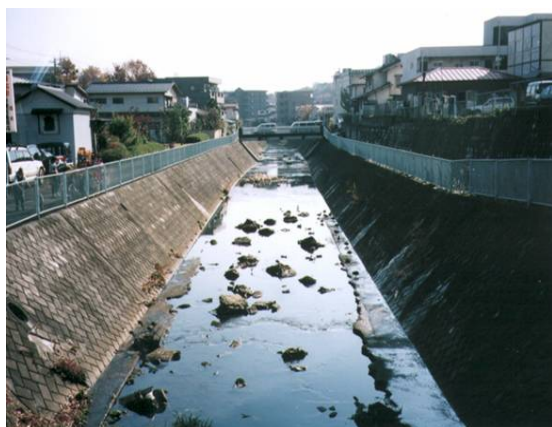
図 3.5.5 早淵川上流 水際部へのアクセスが困難な急傾斜護岸とフェンス
