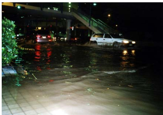
図 3.1.11 道路冠水（平成 16 年 10 月 9 日、台風 22 号、横浜市港北区新横浜）
