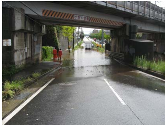
図 3.1.12 道路冠水（平成 26 年 10 月 6 日、台風 18 号、横浜市港北区鳥山町）
