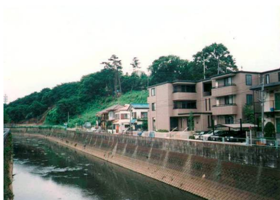
図 3.4.8 矢上川市街地区間 水面まで 5m 近くある。河川沿いは狭く消防車の進入が困難である。
