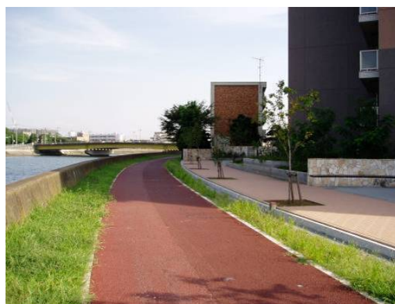
図 3.5.14 芦穂橋上流右岸（公開空地の誘導）
