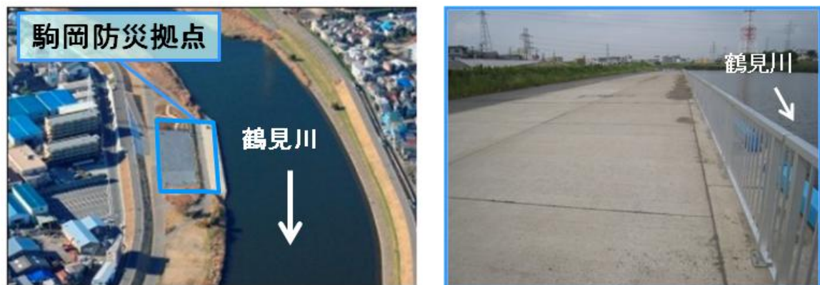
図 3.4.5 駒岡緊急用船着場
