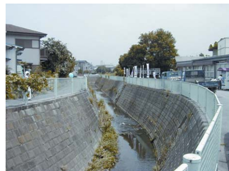
図 3.2.4 真福寺川、水車橋地点
