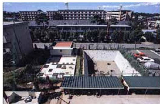
図 2-1-5 浸透型の防災調整池（新河岸川流域）
