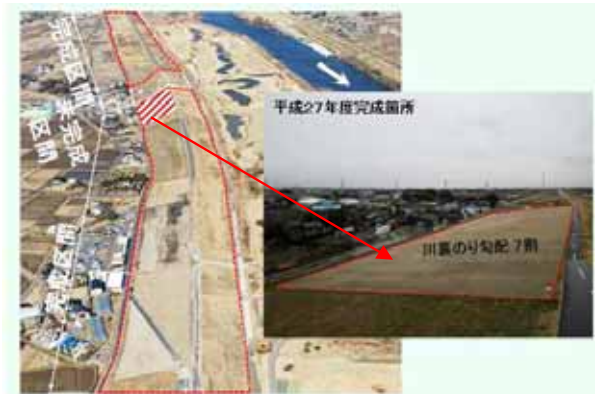
堤防断面拡大による堤防強化(吉川市吉屋地先)
