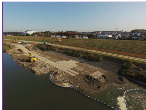
H28. 11. 17日(木)工事現場の状況写真
