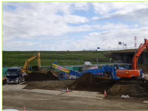
H28. 11. 16日(水)工事現場の状況写真
