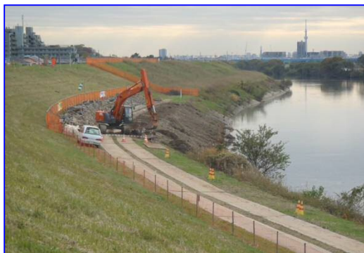
H28. 11. 16日(水)工事現場の状況写真
