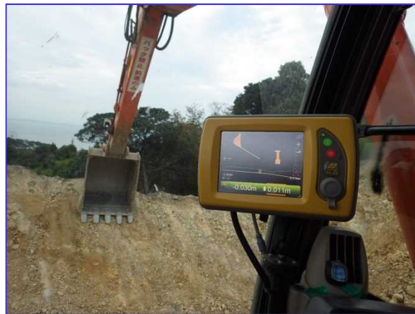
ICTバックホウによる法面整形 (10月4日撮影)
