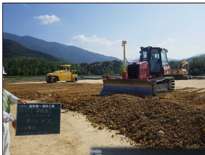
MCブルドーザによる敷均し
