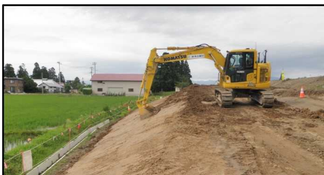
ICTバックホウによる法面整形
