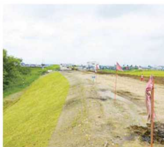
築堤盛り土の状況
