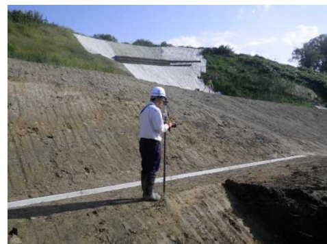
○ 出来形確認の状況 ICTバックホウと同じ設計データを入力した自動追尾型TSを使用して日々の出来形確認を行っている
