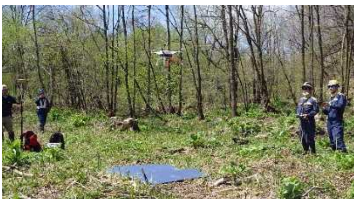
UAV(ドローン)による施工前の測量 (5月12日撮影)
