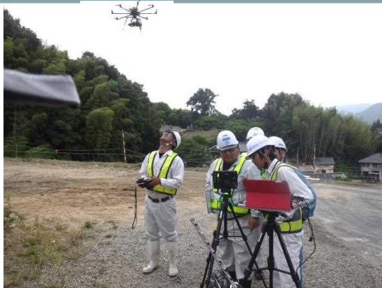
UAV(ドローン)による施工前の測量 ( 6月 15日撮影)
