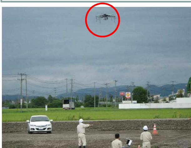
ドローンによる施工前の空中写真測量
