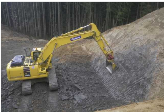
マシンコントロール油圧ショベル による法面整形
