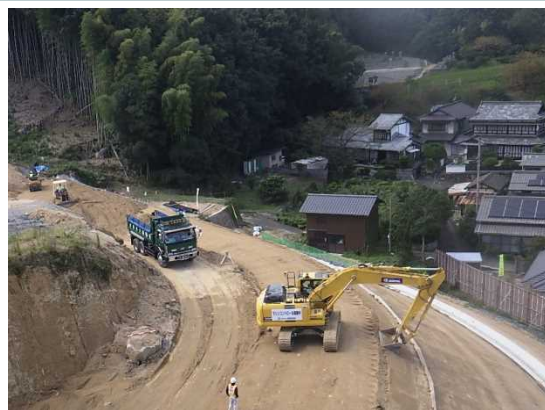
ICTバックホウによる削取整形 ( 10月 7日撮影)
