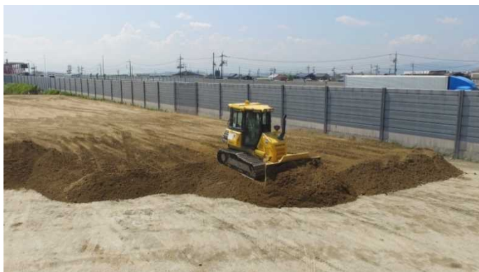
ICTブルドーザによる敷均し(8月19日)
