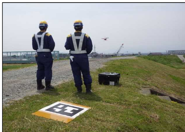
UAV(ドローン)による施工前の測量状況
