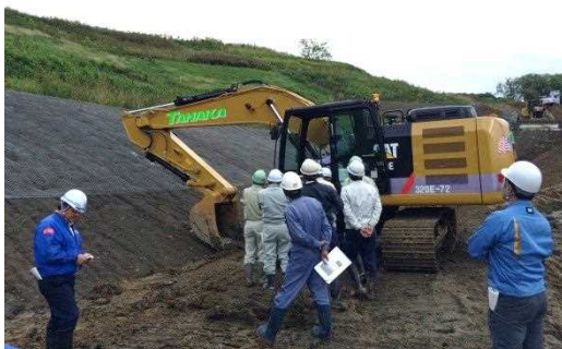
○ ICT技術活用工事現場研修 現場の声(田中産業株)
