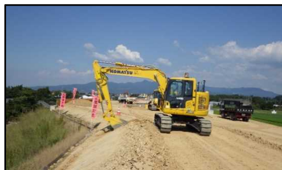
MCバックホーによる切土法面整形
