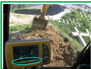
重機運転席内モニター (施工誤差表示)
