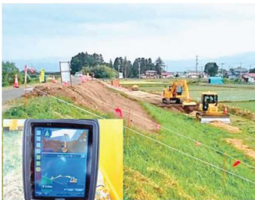
モニターで施工状況を確認しながら（左下）、ICTバックホウで表土を削り取る
