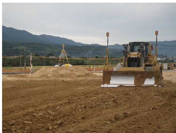
MCブルドーザによる敷均し
