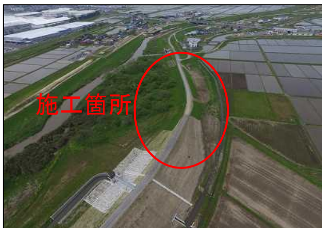
UAV(ドローン)による施工前の空中写真測量
