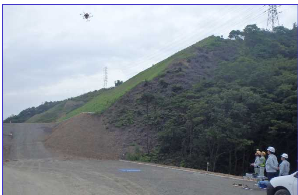
UAV(ドローン)による施工前の測量 (6月9日撮影)
