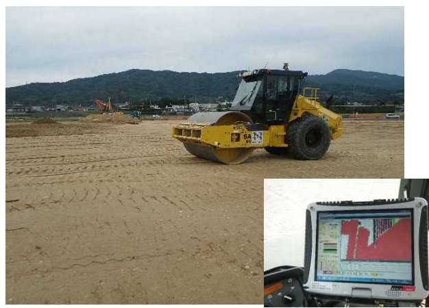
転圧管理システム搭載ローラによる転圧
