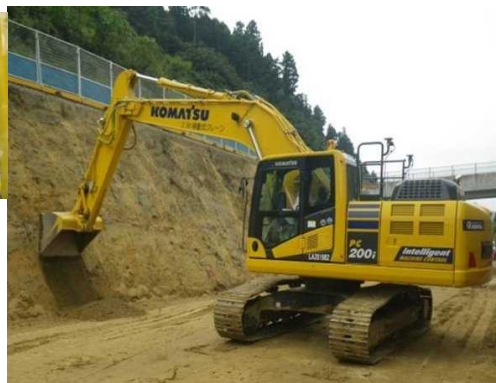
ICTバックホウによる施工
