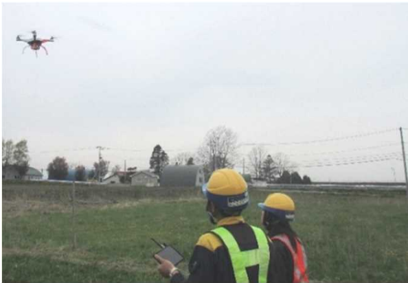
UAV(ドローン)による施工前の測量 (5月10日撮影)
