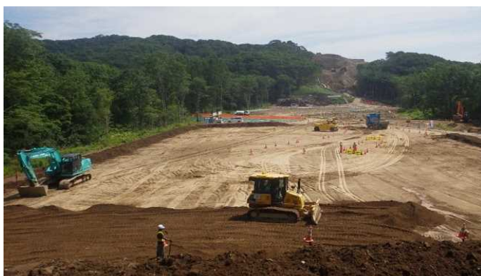
ICTブルドーザによる敷均 (8月5日撮影)
