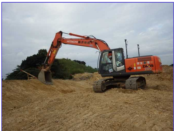
ICTバックホウによる法面整形 (10月4日撮影)
