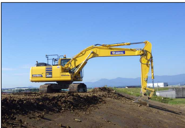
ICTバックホウによる法面整形
