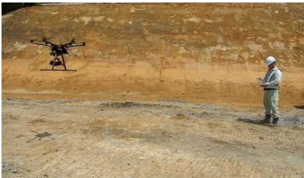
UAV測量の検証を行い。 現場での実効性を確認
