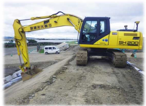
河川堤防の法面整形工におけるMGバックホウでの実効性を確認
