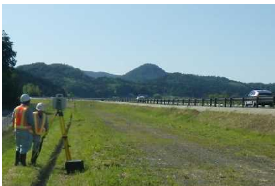
レーザースキャナーによる起工測量
