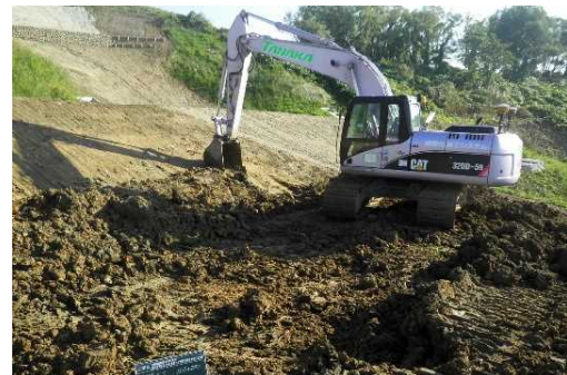
○ ICTバックホウによる法面整形
