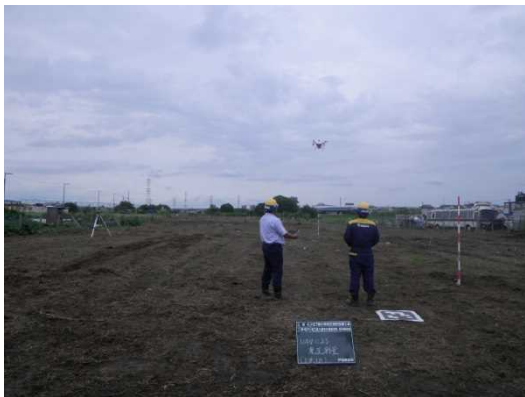
UAV(ドローン)による施工前の測量 (9月15日撮影)
