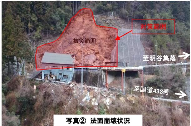
写真② 法面崩壊状況
