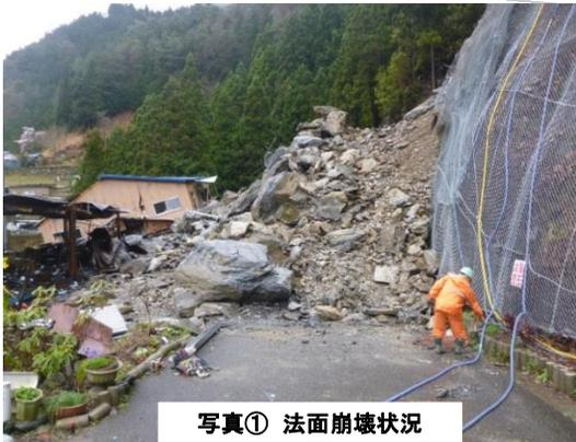
写真① 法面崩壊状況
