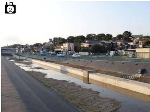
調整池施工後
