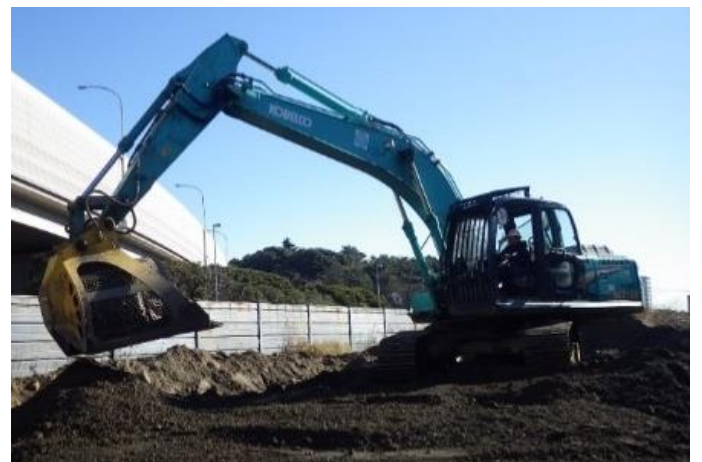
ガラ分別作業の状況
