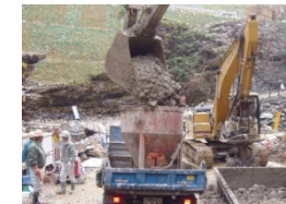
現地発生材料混合状況
