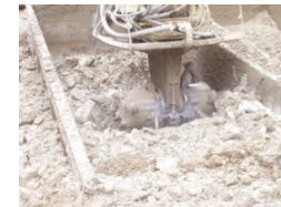
現地発生材料混合状況
