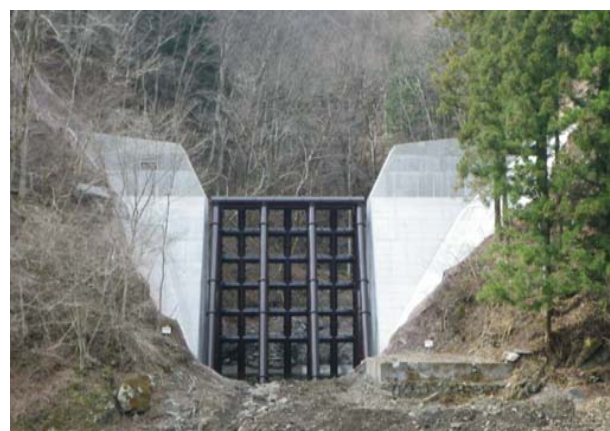
砂防堰堤完成イメージ
