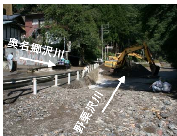
土砂堆積状況
