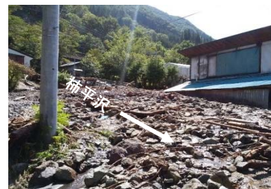
土砂堆積状況
