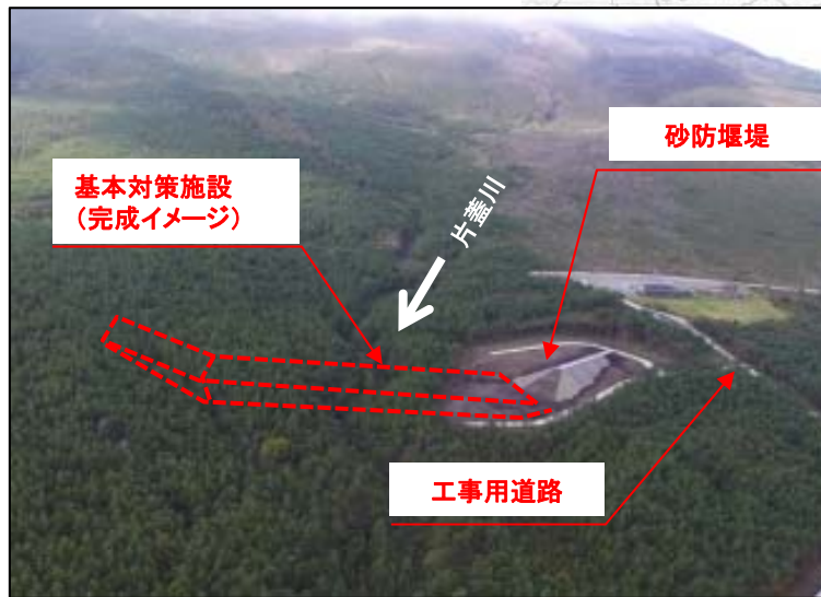
砂防堰堤の整備状況(片蓋川)
