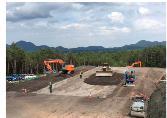
砂防ソイルセメントによる砂防堰堤施工状況 (片蓋川)
