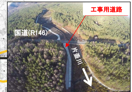
工事用道路の整備状況(片蓋川)
