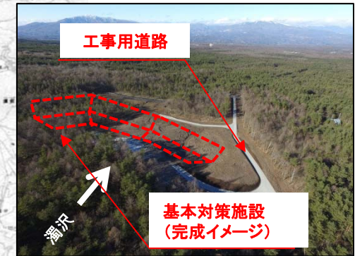
工事用道路の整備状況(濁沢)
