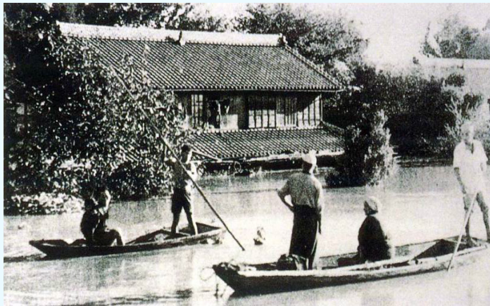
カスリーン台風による古谷村の浸水状況（現川越市）
