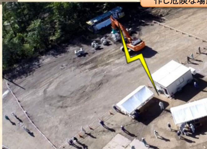
バックホウをカメラからの映像で遠隔操作し危険な場所でも作業が行えます。
