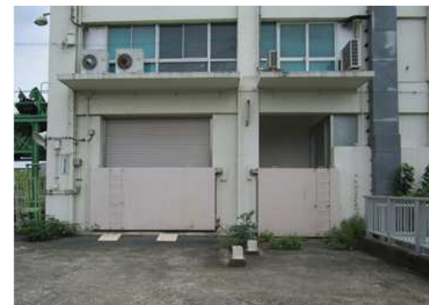
入口にはゲートを設置
