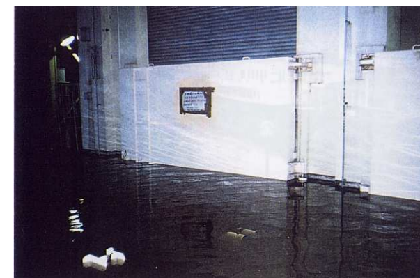
平成11年8月出水では 周辺は冠水したが機場は継続運転した
