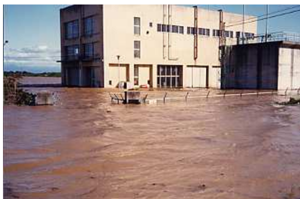
昭和57年9月台風により浸水 エンジンや電子機器が冠水し運転不能に
