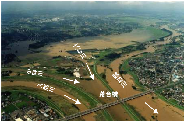
入間川、小畔川、越辺川合流点付近
