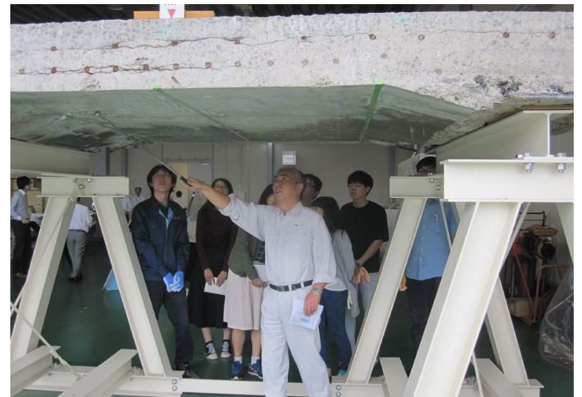
実際に使われていた橋梁断面の損傷を見ながら打音の違いを確認
