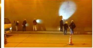
点検実習(打音点検・クラック調査)
