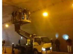
高所作業車による近接点検
