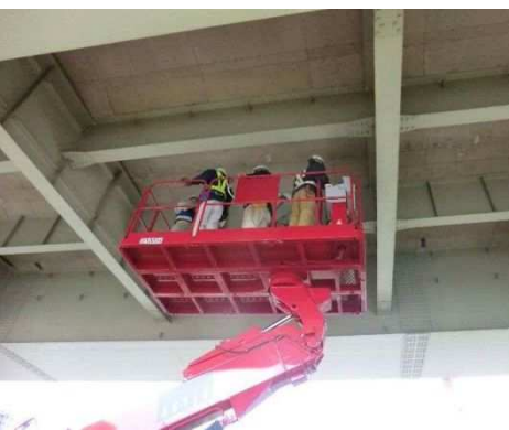
<近接目視点検>
