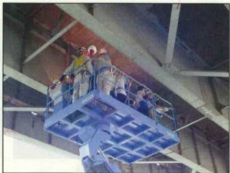
ひび割れや、塗装の剥がれを間近で確認
