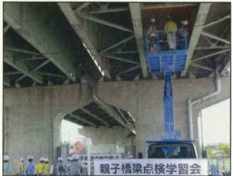
高所作業車に乗って、橋の裏側を点検
