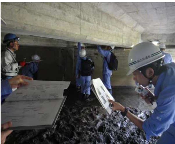
橋梁点検状況
