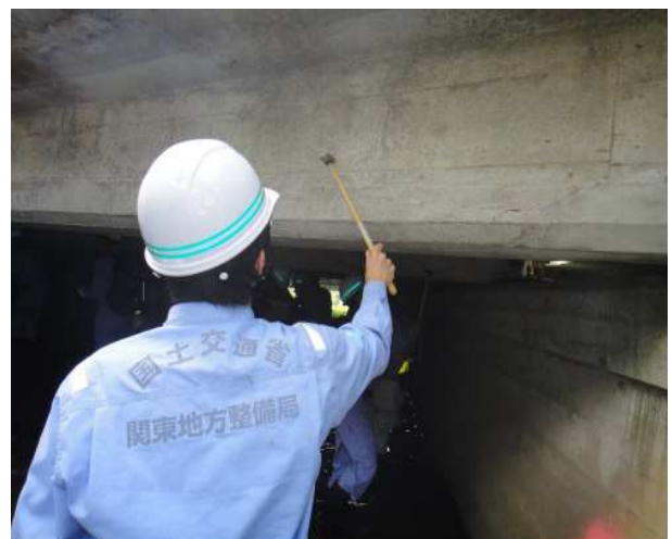
橋梁点検状況
