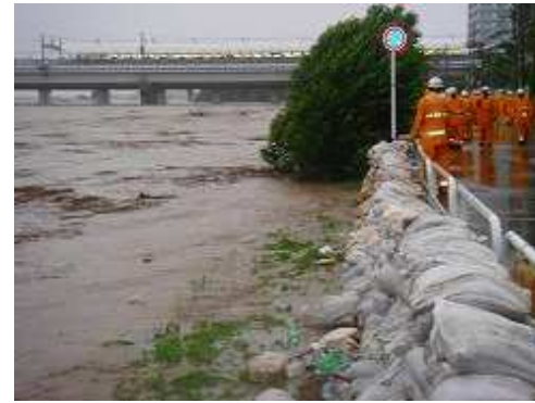
水防活動(土のう積み)
