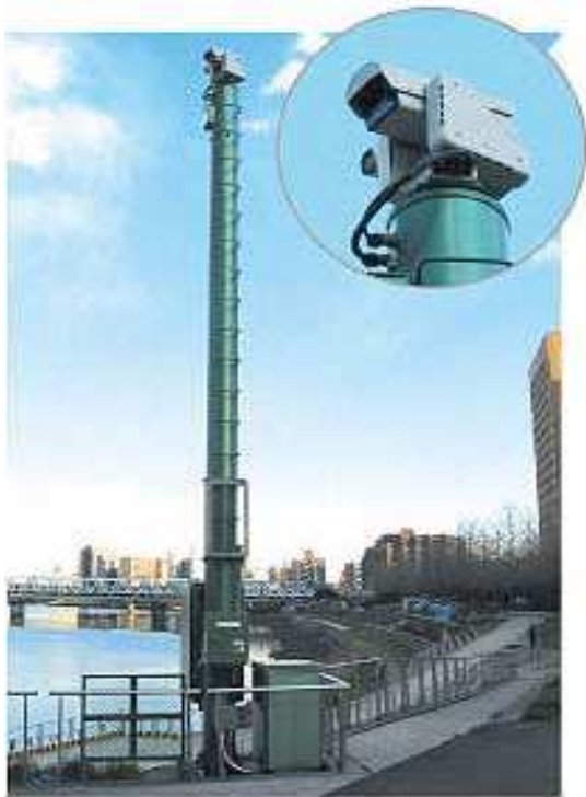
○CCTVカメラ等の設置による情報提供
