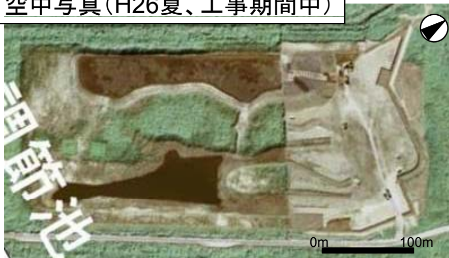
空中写真（H26夏、工事期間中）
