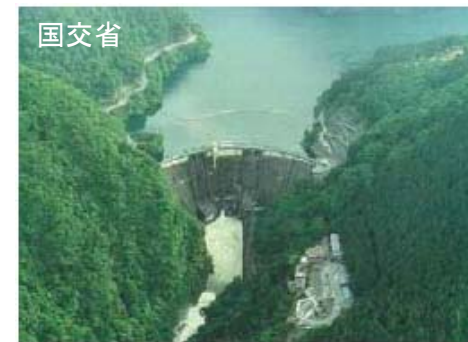
二瀬ダム(昭和36年完成)
