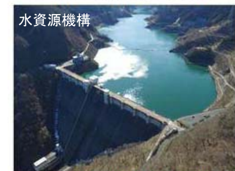
浦山ダム(平成11年完成)
