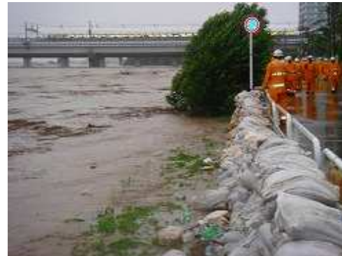
水防活動（土のう積み）
