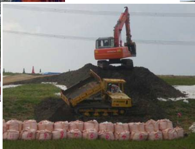
建設業者による水防支援 （イメージ）
