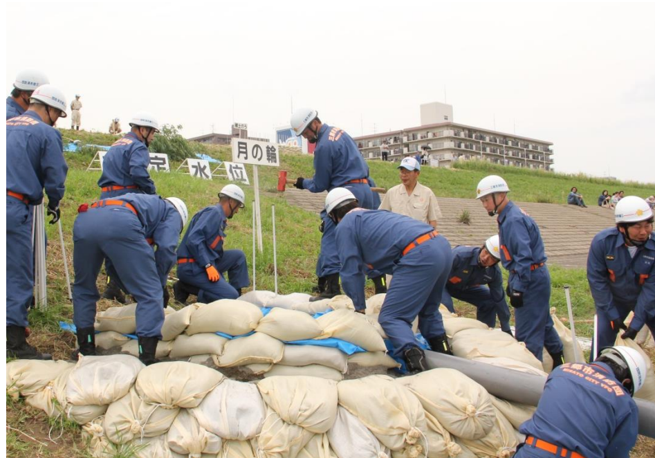
三郷市水防訓練：水防工法 月の輪
