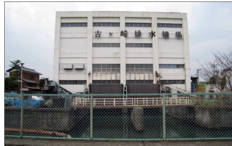
古ヶ崎排水機場
