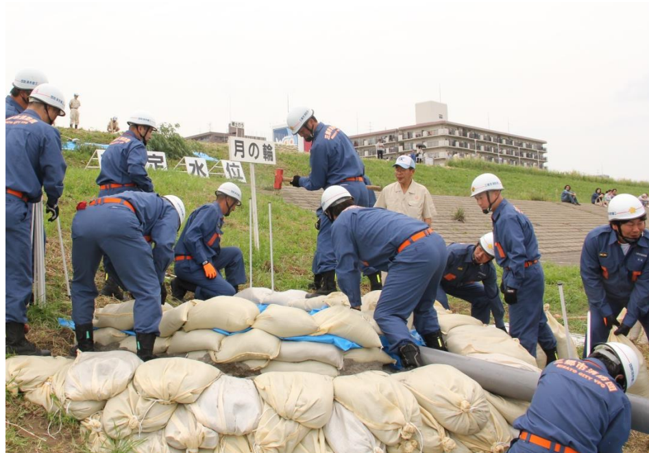
三郷市水防訓練：水防工法 月の輪
